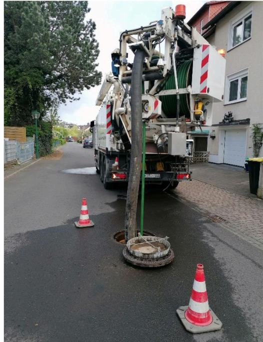
Die Arbeiten haben im Ortsteil Weimar begonnen und werden in Richtung Kläranlage fortgesetzt. Die Untersuchung erfolgt vor Ort mit einer fahrbaren Kamera, die von einem TV-Untersuchungswagen aus gesteuert wird. Die aufgenommenen Bilder werden später ausgewertet und nach Schadensklassen eingeteilt, um Prioritäten für notwendige Sanierungen festzulegen.
